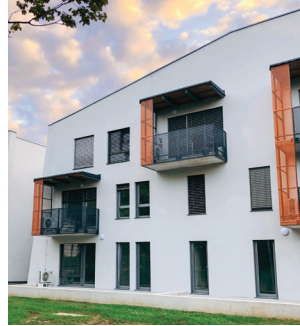
25 luxe energiezuinige appartementen in Maribor (Slovenië)
