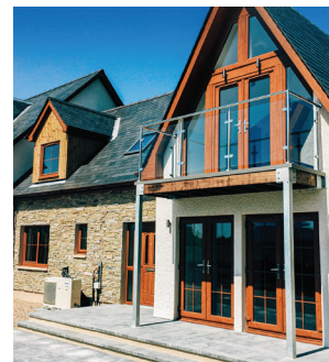
Tower Ridge Courtyard in Schotland (Verenigd Koninkrijk)
