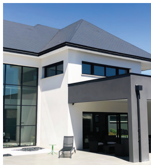
610m2 huis met vloerverwarming en DHW in Saint-Prest (Frankrijk)
